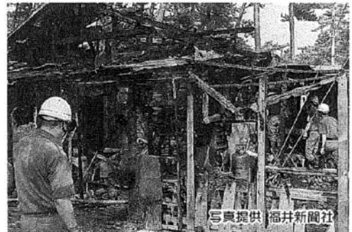
高浜町営住宅火災
