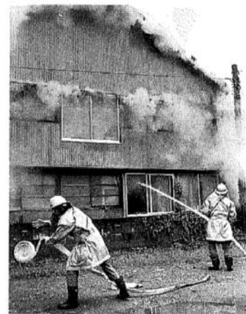
日吉作業場火災
