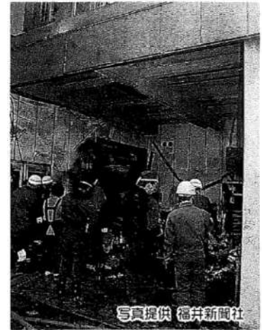
放火による店舗火災
