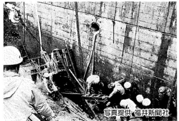
コンクリート生埋め事故
